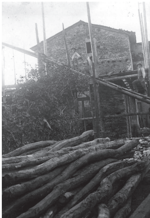
Da L'Eco di Olonio S. Salvatore (dicembre 1924): inizio dei lavori di ristrutturazione della Casa.
