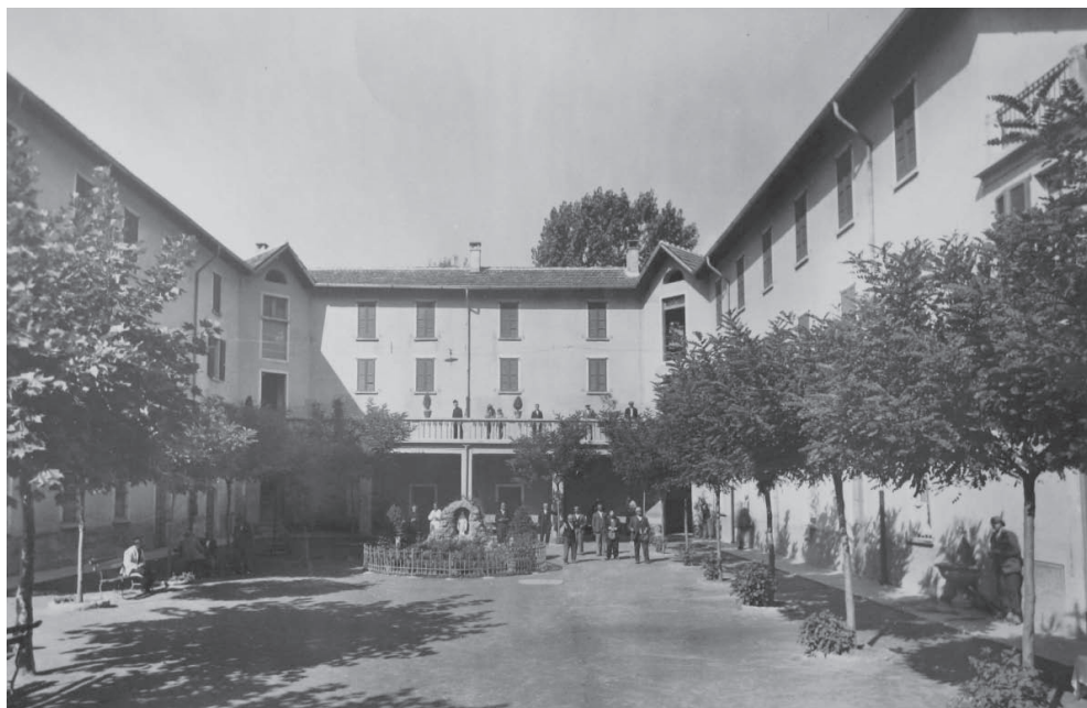
Il corpo centrale della Casa Madonna del lavoro. (anni '40)
