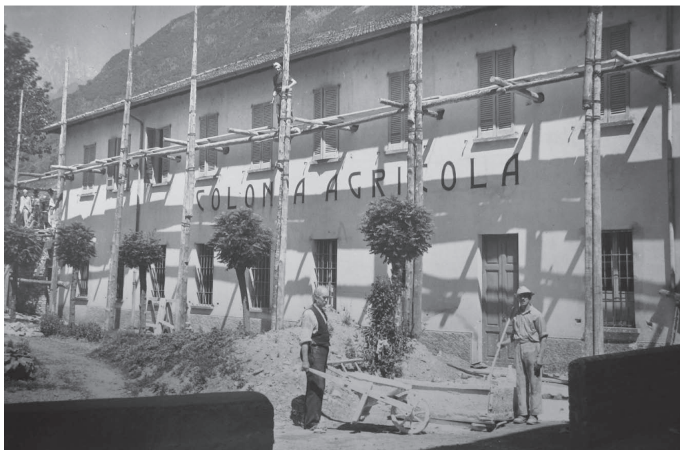
1931: Ultimi lavori all'ala che, partendo dal corpo principale della Casa, volge verso Nord. Nel 1949-50 sarà sopraelevata di un II piano. Oggi, al pianterreno, vi è l'animazione della RSA.
