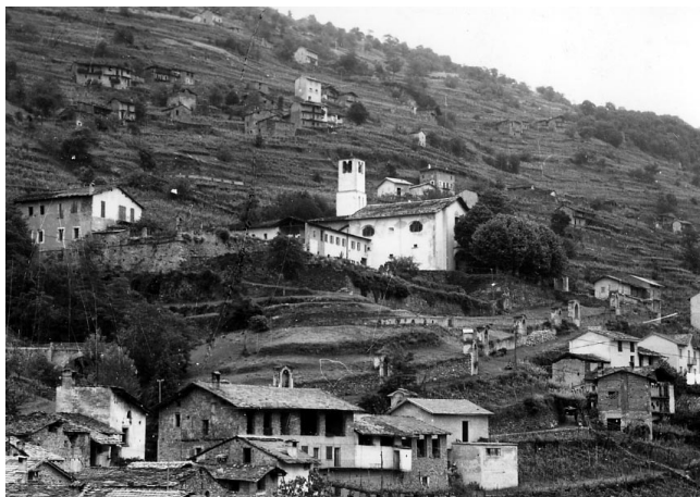
Traona, convento, sede del primo tentativo di fondazione da parte di don Guanella (1879-1881).
